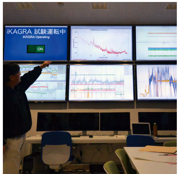
図5 KAGRA の試験運転を行う制御室 Control room in the KAGRA Data Analysis Building
