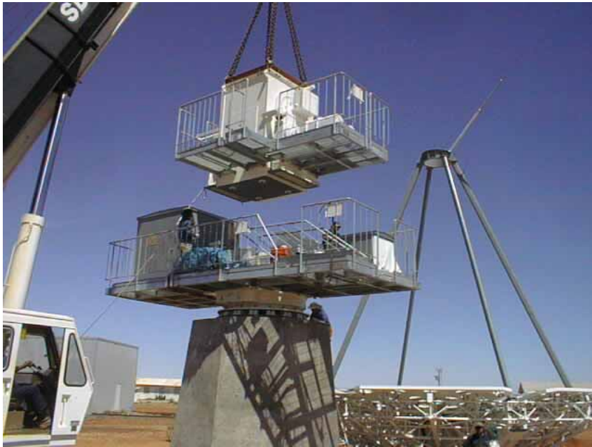
Craning up the EL structure (Mar.'02)
