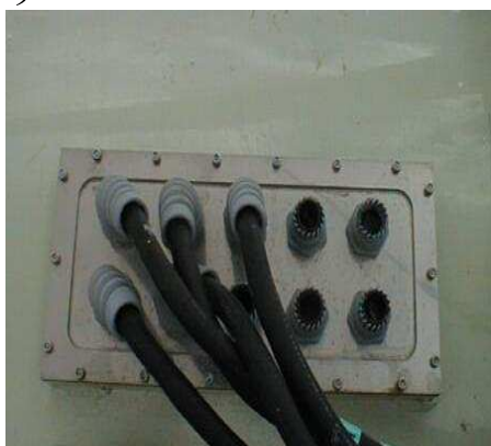
図 3.19: 3号機のカメラで使用しているパネルとケーブルエントリー 図 3.20: 4号機のカメラで使用しているパネルとケーブルエントリー
