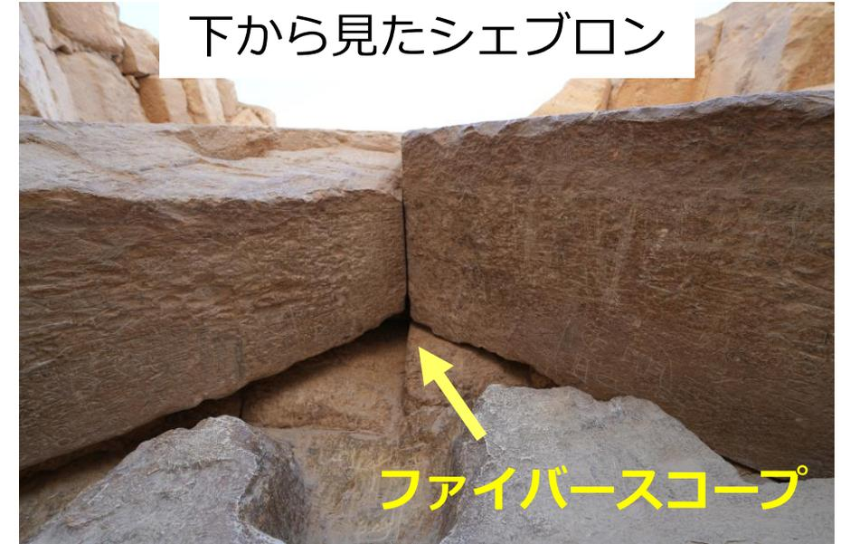
シェブロンとその背後の石組みの隙間を利用してファイバースコープを挿入
